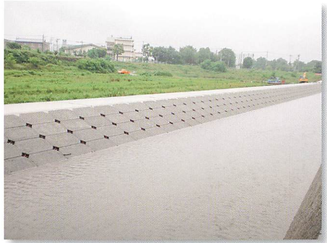
前橋土木事務所
