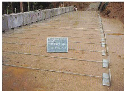
補強材・アンカー材設置状況
