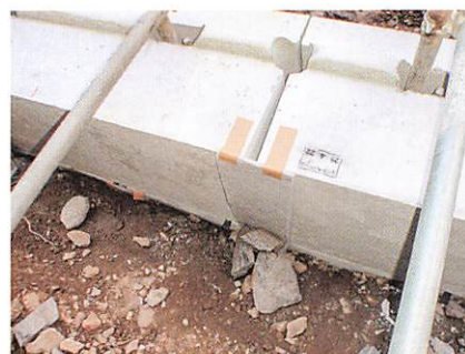
吸出し防止材施工例 A=0.133m 2 /ヶ所
