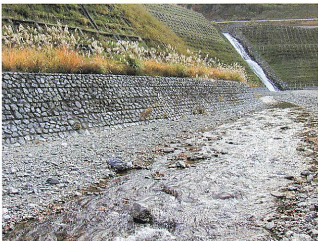
浦山ダム建設事務所
