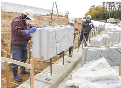
壁面パネル設置状況
